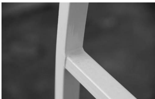
Фото 1. Сварка элемента торца
