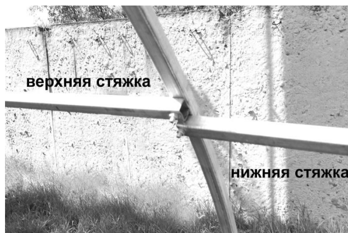
Фото №2. Стяжки (стрингеры) в шахматном порядке.
